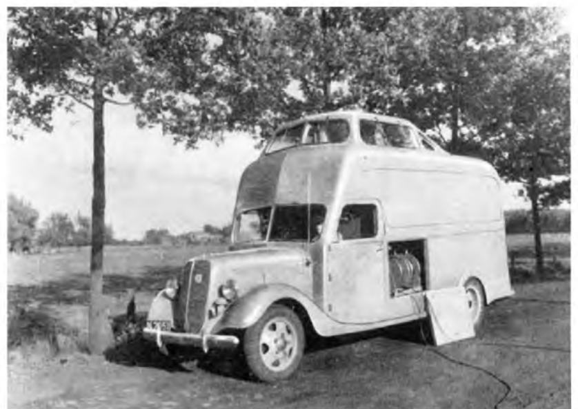
Ein Tonaufnahmewagen mit oben aufgebauter schalldichter Reportagekabine und Philips-Miller-Tonaufzeichnungsgerät, mit dem man auch während der Fahrt über unebenes Gelände gute Aufnahmen erzielen kann
